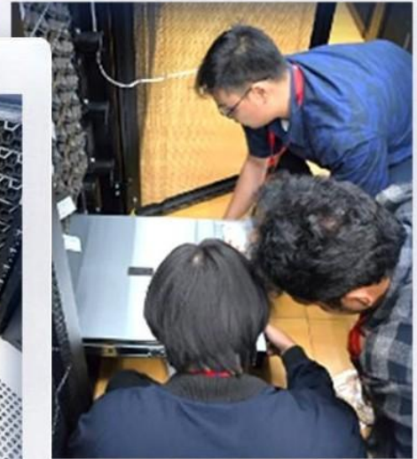
Pengerjaan Mounting Server
