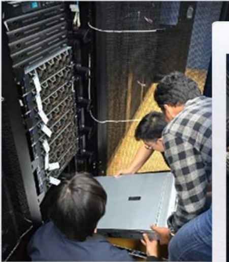
Pengerjaan Mounting Server
